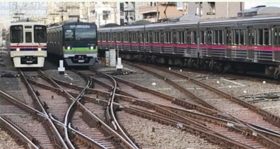
京王電鉄京王線笹塚駅のシーサス・クロッシング。複数の線路がハサミを広げたように交差し、分岐してゆく 写真提供：京王電鉄株式会社
