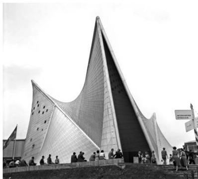
1958年ブリュッセル万博における電気機器メーカー・フィリップス社のパビリオン。ル・コルビュジェの建築事務所に在職中のクセナキスが設計した。柱を持たない構造の会場内ではヴァレーズの電子音楽「ポエム・エレクトロニク」が流された
